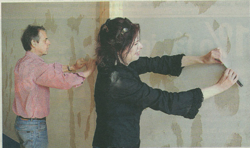
Det var mycket jobb med att ta ner de stora speglarna som tidigare fanns i gymmet. Olle Widén och Petra Gunnarsson skrapar bort resterna.
